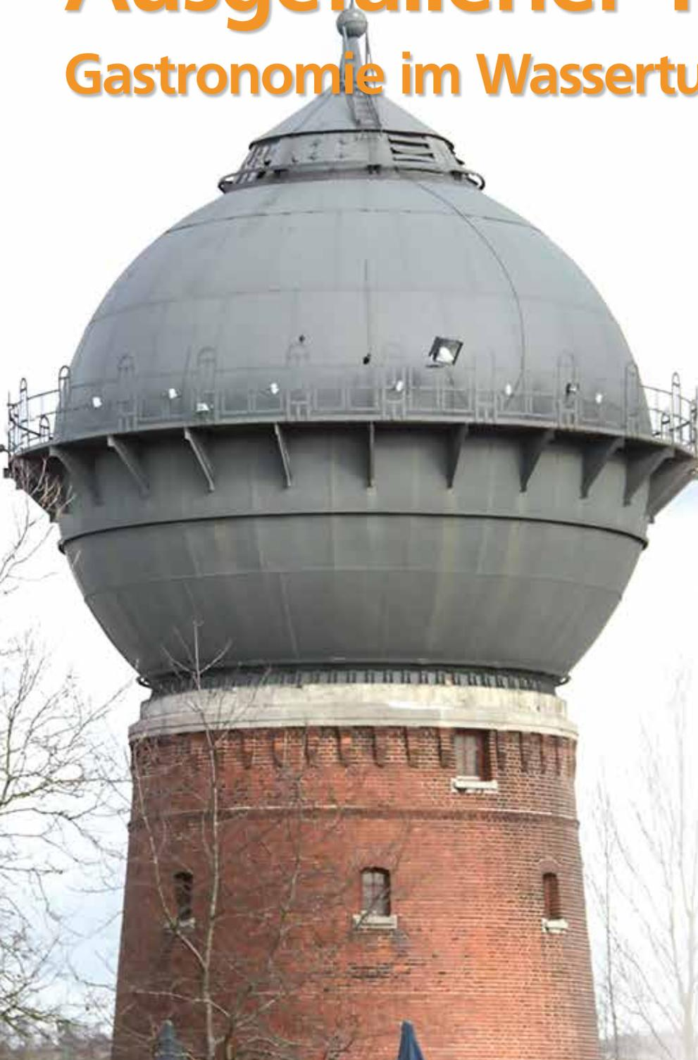
Der Crailsheimer Wasserturm gehört zur alten Eisenbahnerstadt wie der Horaff und ist ein Industriedenkmal: 1912 errichtet, diente er der Wasserversorgung der Dampflokomotiven. Noch um 1960 wurden zu Spitzenzeiten bis zu 60, ja 70 Lokomotiven täglich mit Wasser versorgt. Dabei flossen pro Tag 1 200 bis 1 400 Kubikmeter Wasser durch den Turm.
